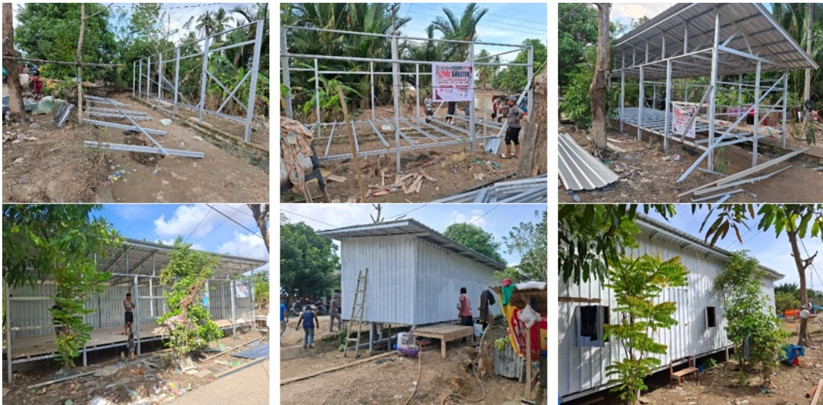
Gambar 3. Dokumentasi tahapan proses pengerjaan shelter
